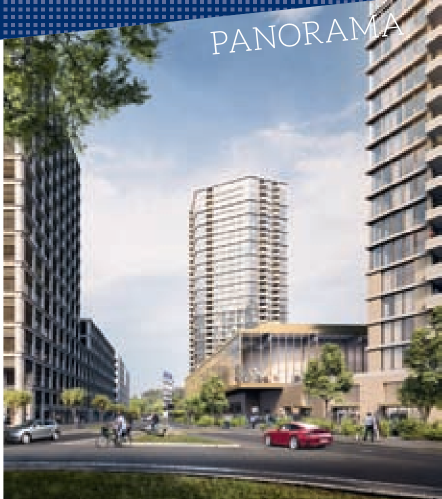
Der Blick auf den Neubaukomplex vom Mattenhof-Kreisel: Rechts die Halle zwischen den zwei Wohngebäuden, links das Mobimo-Gebäude, das sich aktuell im Bau befindet. Die Strasse in der Mitte führt zur Unterführung Richtung Allmend
